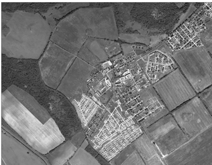
Obrázok 2 Príklad výstavby rozsiahleho rezidenčného areálu. Lokalita Čierna Voda (obec Chorvátsky Grob) bola pôvodne menšou poľnohospodárskou usadlosťou, ktorá sa v priebehu niekoľkých rokov premenila na hustú sieť rodinných domov s typickými znakmi moderných suburbií ako je napr. malá rozloha parciel, vysoká zastavanosť pozemkov, slepé ulice a pod. Snímky pochádzajú z rokov 2000 (hore) a 2009 (dole). Zdroj: Google Earth
